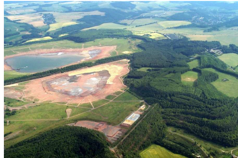
Absetzanlage Culmitzsch, Quelle: mapio.net Kontaminierter Schrott in Kassetten mit Beton vergossen; kontaminierter Bauschutt
